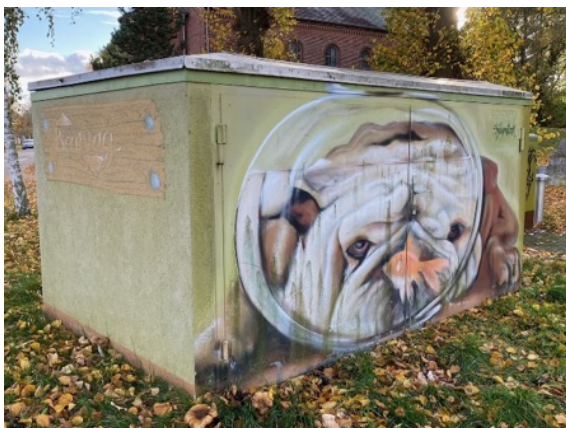
Estación de bombeo
