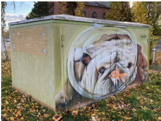
Stazione di pompaggio
