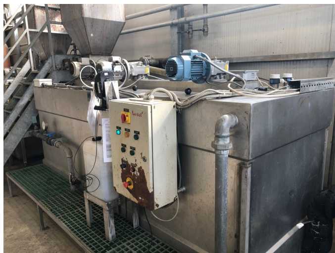
Photo 1 — Poste de préparation du polymère. La pompe doseuse et le bidon de produit sont simplement posés au pied du préparateur, à côté de l'armoire de commande.
