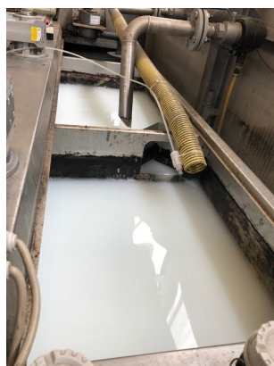
Foto 2 — Punto di iniezione: un tubo sottile fissato sulla tubazione esistente porta il prodotto direttamente nella soluzione di polimero, all'interno della vasca.
