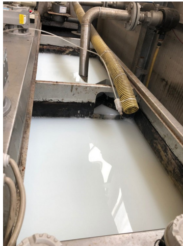
Foto 2 — Dosierstelle: Ein dünner Schlauch, an der vorhandenen Leitung befestigt, führt das Produkt direkt in die Polymerlösung im Behälter.
